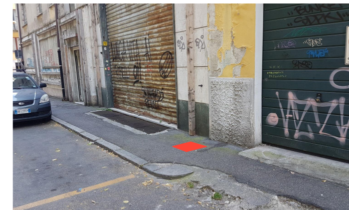
NUOVO POZZETTO D'ISPEZIONE IN CORRISPONDENZA DEL COLLEGAMENTO ALLA TUBAZIONE ESISTENTE SU VIA PORTA PILE NEI PRESSI DEL PASSO CARRAIO CIV. 17/D
